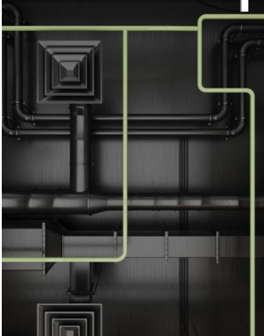
Потолок крашенный по RAL7021 с открытыми коммуникациями
